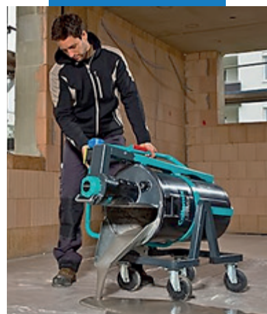
Монтаж растворной смеси Mapefloor 11 (Мапeфлор 11)
