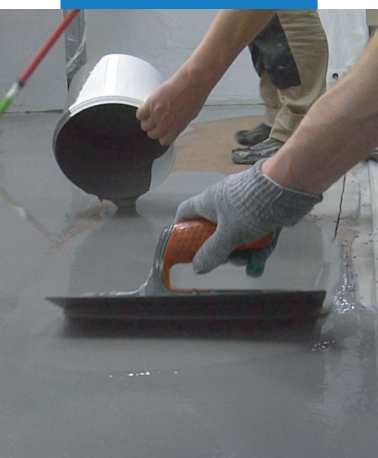
Монтаж растворной смеси Mapefloor 11 (Мапеплор 11)
