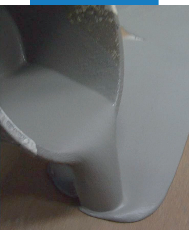
Монтаж растворной смеси Mapefloor 11 (Мапеплор 11)
